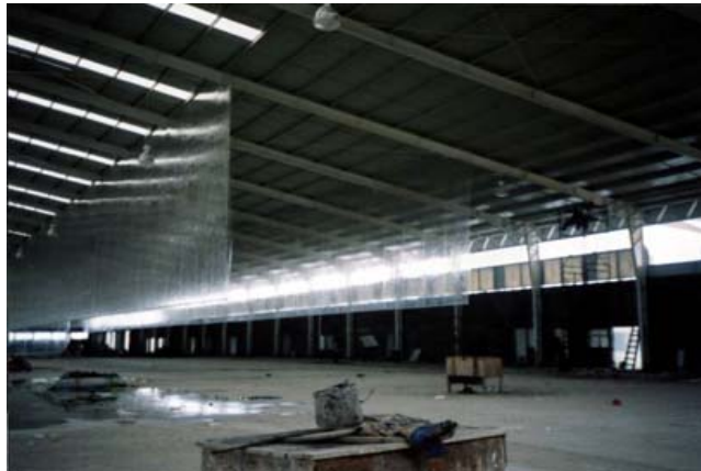
Gambar 7.27 Ventilasi di Pabrik
