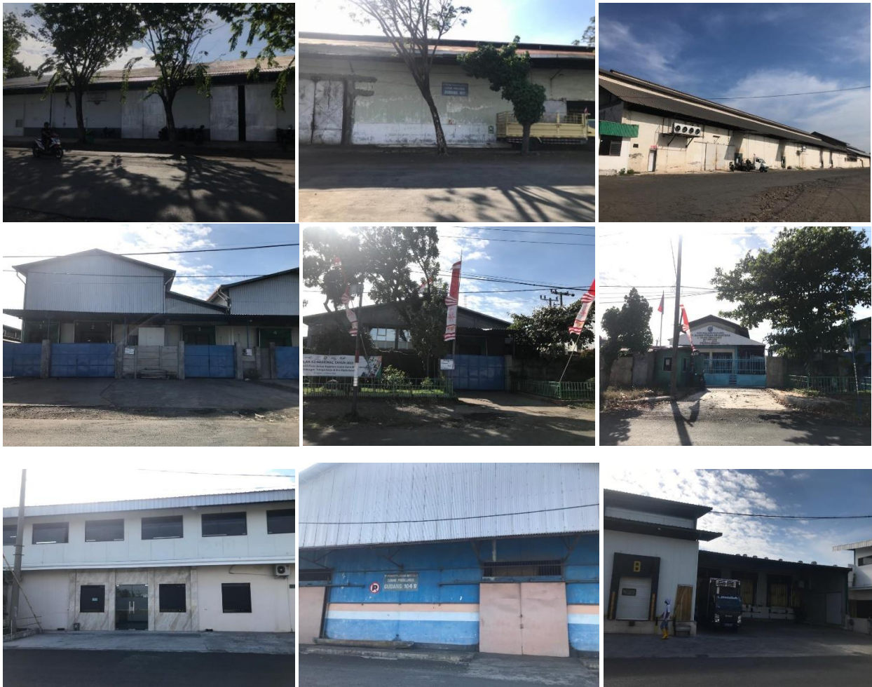
Gambar Lampiran 13 Gudang - gudang di Pelindo Tanjung Tembaga
