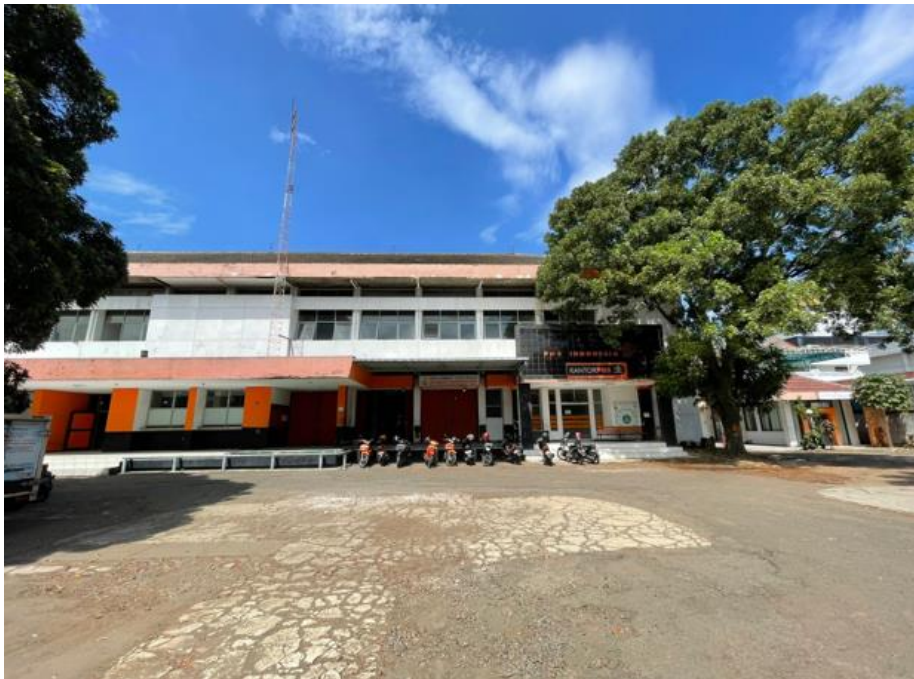
Gambar 5 Bangunan depan MPC Bandung
