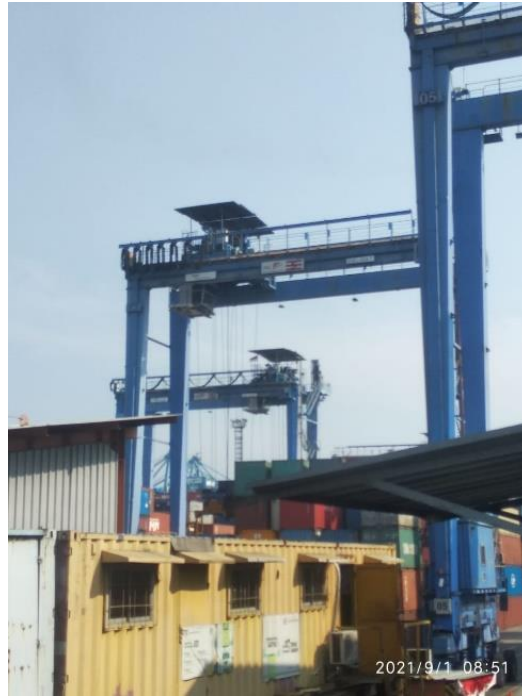
Gambar 1. 9 : Area Kerja IPC TPK, Site Office Terminal 3 Pelabuhan Tanjung Priok
